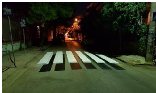
Κατασκευή 3D διαβάσεων.
