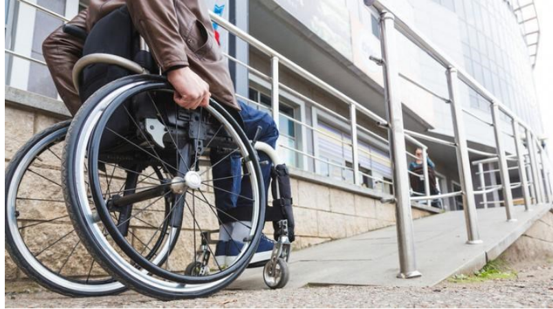
Εικ. 16, Ράμπα για ΑμεΑ σε είσοδο κτιρίου, πηγή: google images
